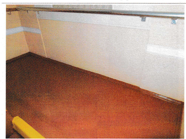
Фото №18 – Пути движения внутри здания (лестницы)
