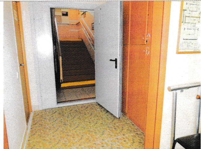
Фото №20 - Пути движения внутри здания (двери)
