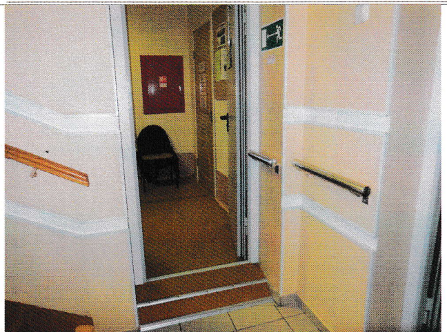
Фото №21– Пути движения внутри здания (двери)
