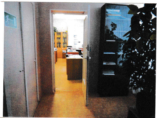
Фото №25 – Пути движения внутри здания (двери)
