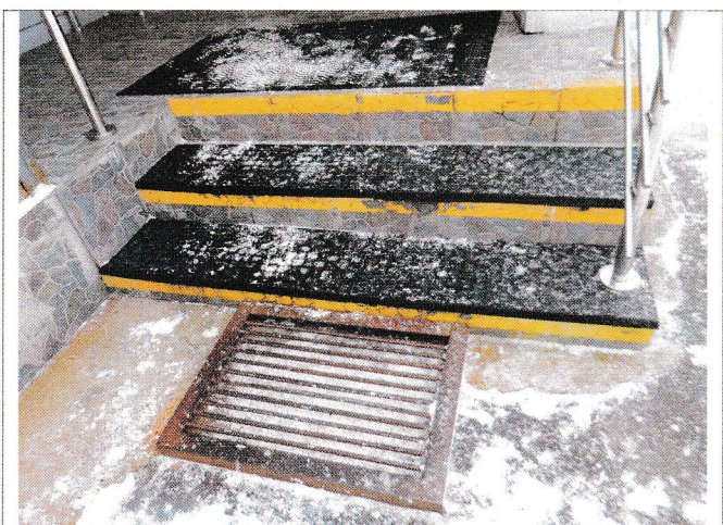
Фото №5 – Наружная лестница
