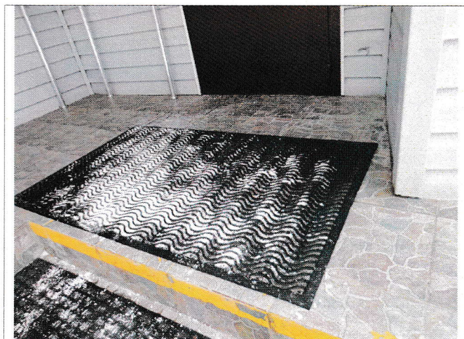
Фото №8 – Входная площадка
