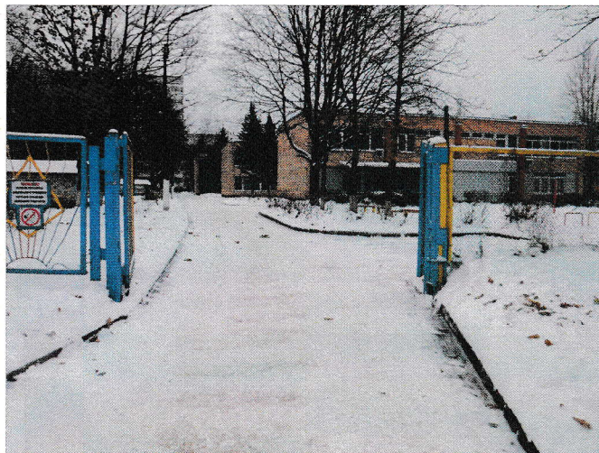
Фото №2 – Вход на прилегающую территорию
